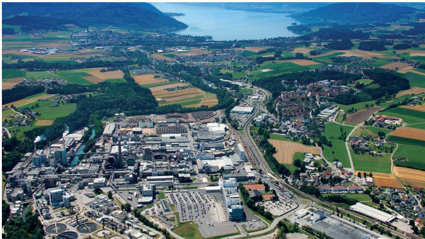
Die Lenzing AG produziert auf ihren eigenen Produktionshallen in der oberösterreichischen Marktgemeinde Lenzing Sonnenstrom aus Verbund-Photovoltaik-Anlagen.
