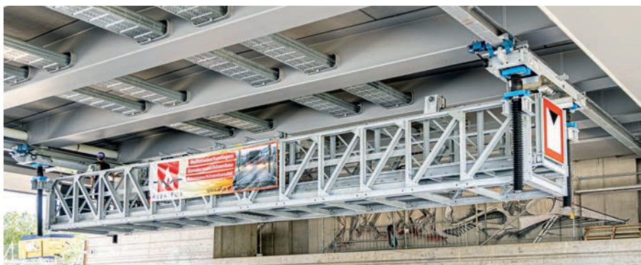
Brückeninspektionswägen ermöglichen Prüfarbeiten, ohne den Verkehr zu beeinträchtigen.
