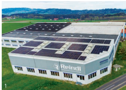
Die firmeneigene Photovoltaikanlage deckt den Jahresbedarf des Firmenstandorts.
