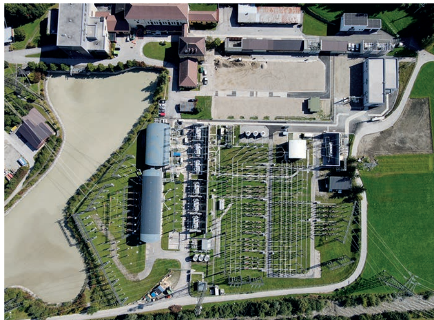
Die 1949 errichtete 110-kV-Schaltanlage des Umspannwerks, zu dem auch je eine 220- und eine 380-kV-Anlage zählen, war nach langer Betriebsdauer erneuerungsbedürftig.
