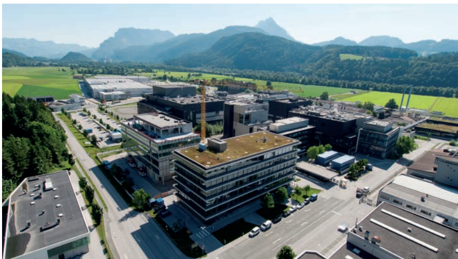
Der Novartis Campus in Schafte­nau soll zum größten und innovativsten Standort zur Herstellung von Biopharmazeutika in Österreich werden.
