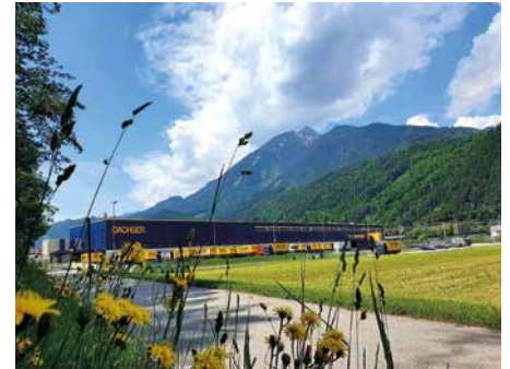
DACHSER-Logistikzentrum Tirol in Stans
