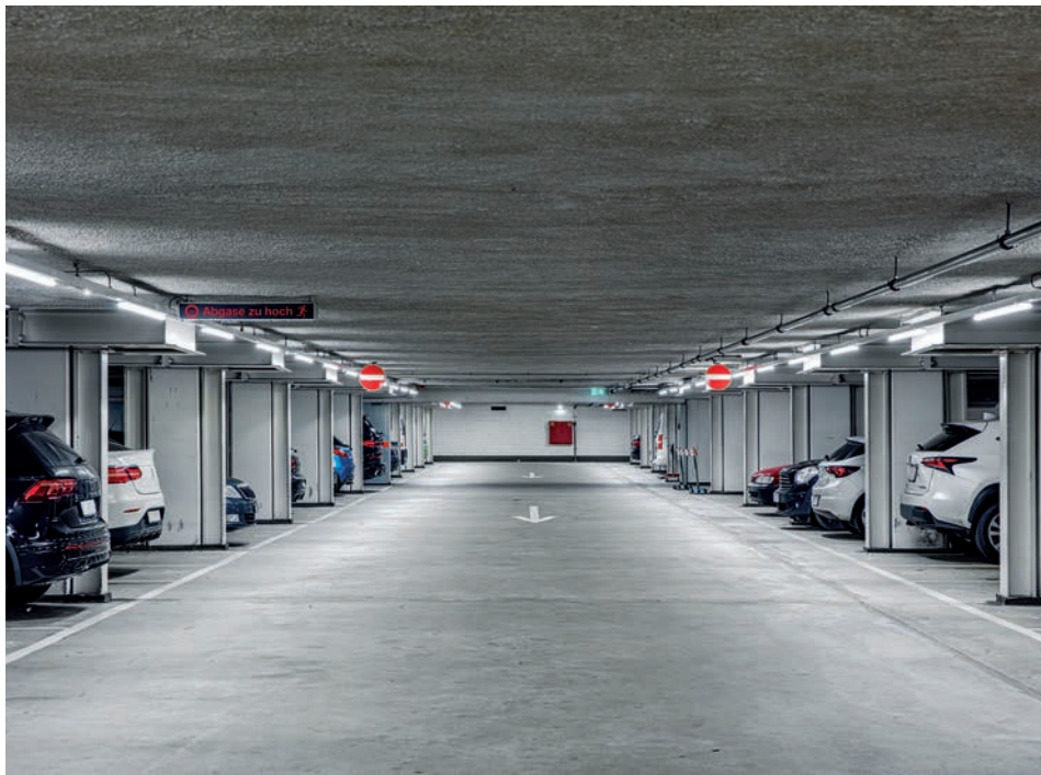
Im Rahmen eines Sanierungsprojekts wurde das Gundeli-Parkhaus in Basel mit der neuesten Version des Lichtbandsystems Tecton modernisiert.
