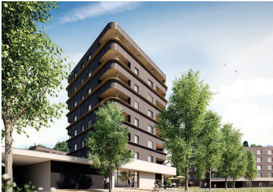
In Lustenau entsteht in Zusammenarbeit mit der Alpenländischen Gemeinnützigen Wohnbau GmbH und der Raiba Lustenau Immobilien GmbH & Co OG ein Gebäudeensemble mit vier Baukörpern, darunter ein achtstöckiges Holzwohnhaus.
