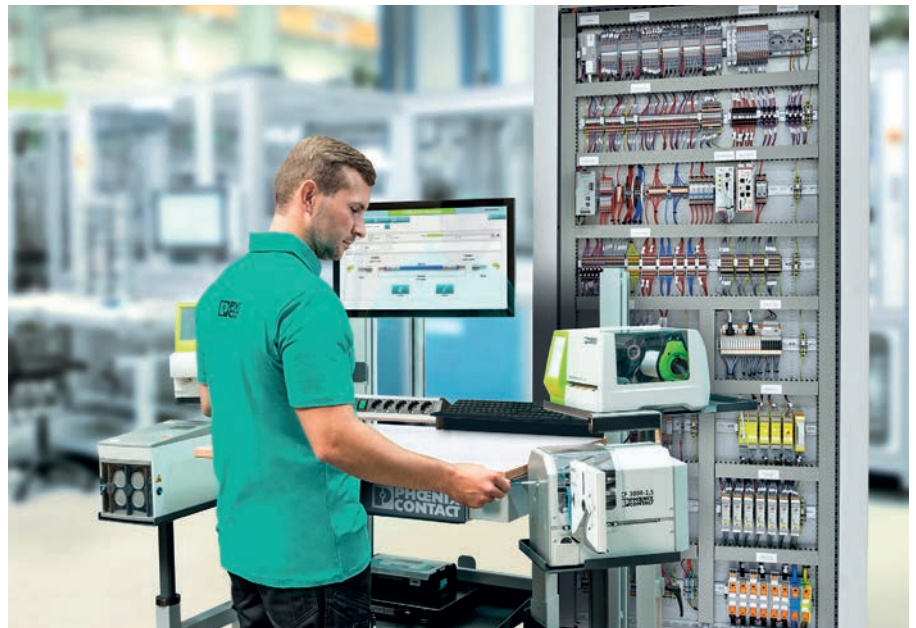
Der Prozess der Leitervorbereitung lässt sich durch die digitale Bereitstellung von Daten aus dem Engineering effizient und fehlerfrei gestalten.
