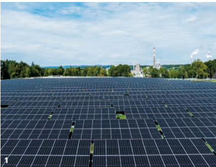
Die neue Anlage lässt eine jährliche CO 2 -Ersparnis von rund 4.400 Tonnen erwarten.
