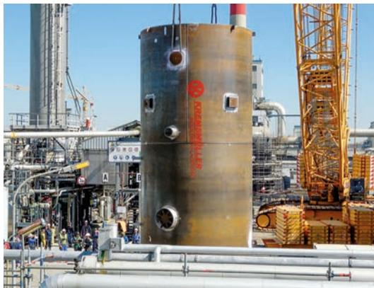
Der Einhub einer neu gefertigten Anlagenkomponente
