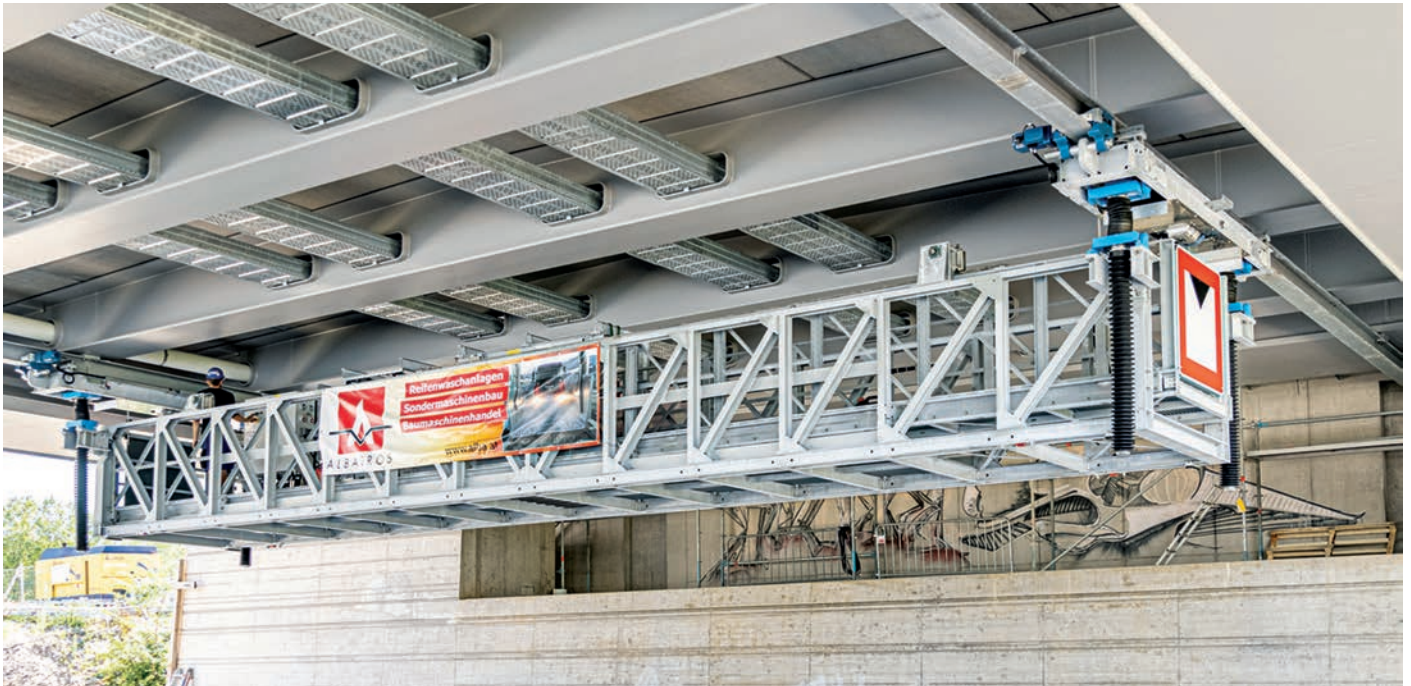
Brückeninspektionswägen ermöglichen Prüfarbeiten, ohne den Verkehr zu beeinträchtigen.
