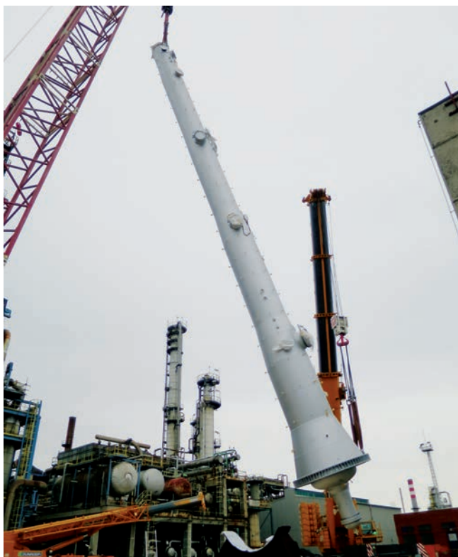
Reaktor bei der Montage in der ungarischen Raffinerie
