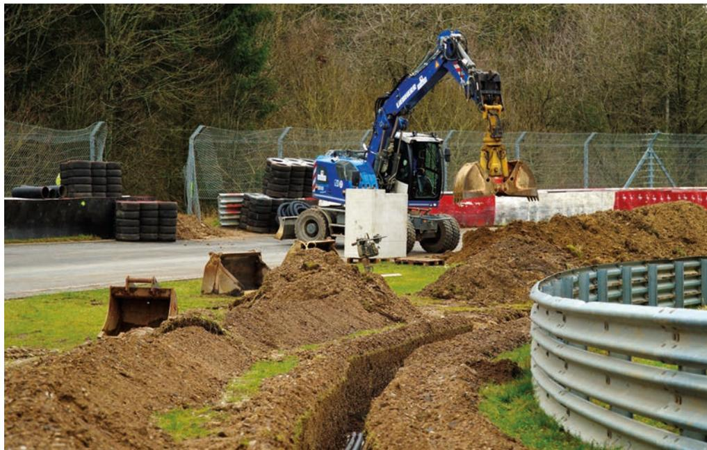
Für erste Tests wurden HD-Kameras entlang eines 2,8 Kilometer langen Streckenabschnitts installiert und mit Glasfaser angebunden.
