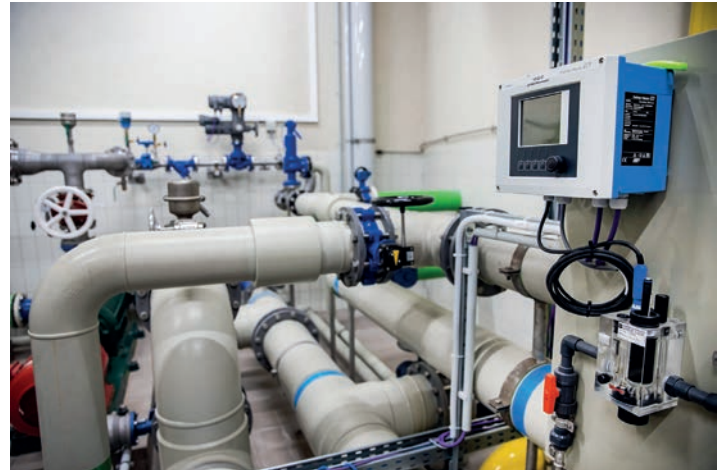
Axel Grether, Wassermeister der Gemeinde Steinen, überwacht am Bildschirm die aktuellen Quellschüttungen in Hägelberg (links). Bei der Aufbereitung des Rohwassers für das Trinkwassernetz wird im Rahmen der Qualitätsanalyse auch der pH-Wert bestimmt (rechts).
