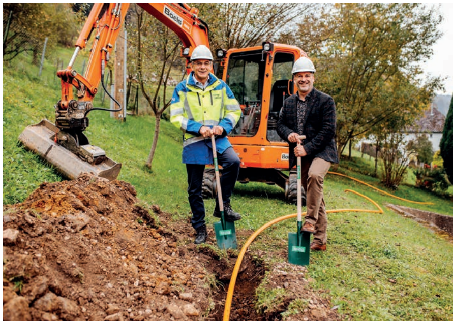
Josef Polster (l.) und Günther Vallant (r.) beim Spatenstich für den Glasfaserausbau in Frantschach.
