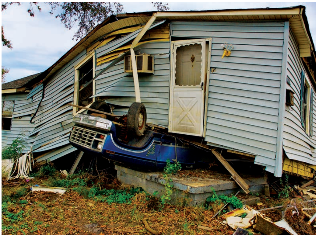
Hurrikanschäden in New Orleans 2018
