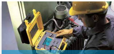
Messung & Prüfung der elektrischen Sicherheit
