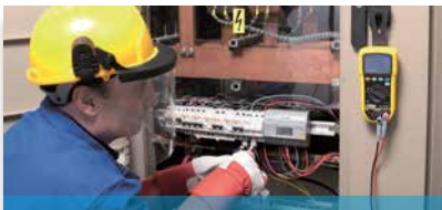
Messung bei Niederspannung
