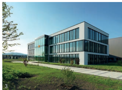
Der Maplan-Standort im Wirtschaftspark Kottlingbrunn ist seit 2016 in Betrieb.
