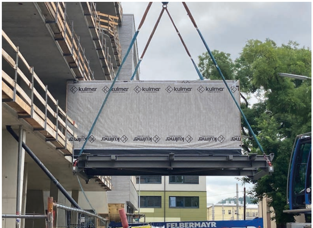
Die Kiubo-Module werden einfach in die bestehende Rahmenkonstruktion „eingeschoben“.
