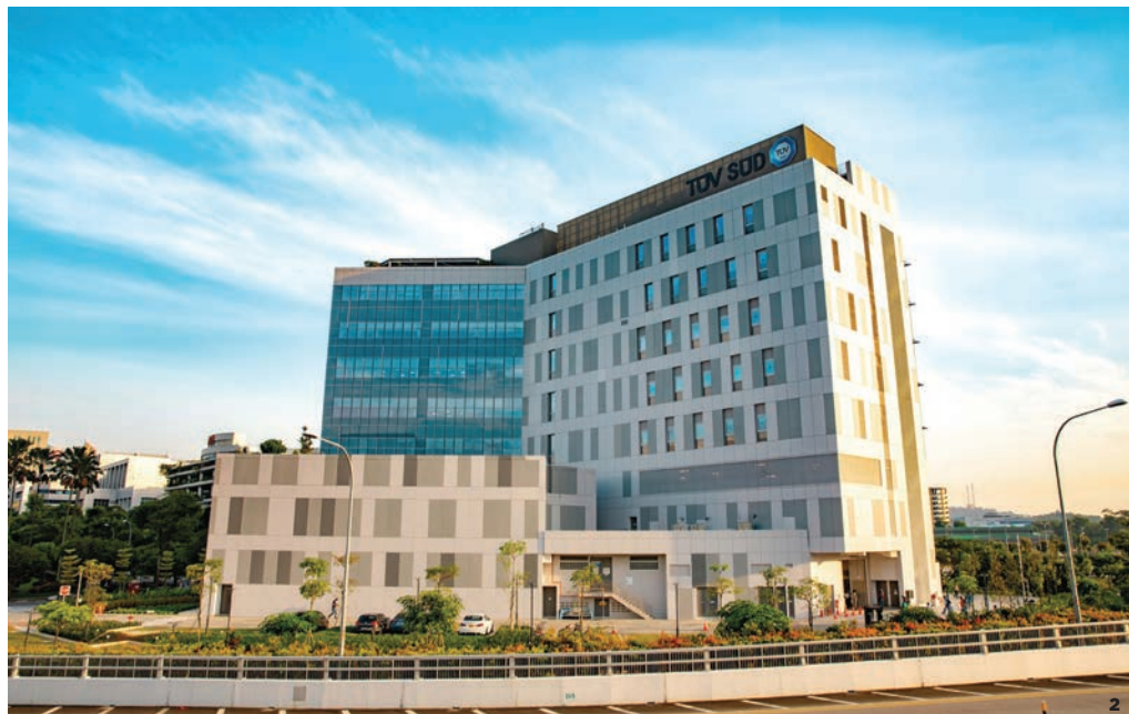
Im Rahmen der konzernweiten Initiative für klimafitte Gebäude wurde das neue Headquarter von TÜV SÜD Singapur 2020 nach modernsten Nachhaltigkeitsanforderungen fertiggestellt.
