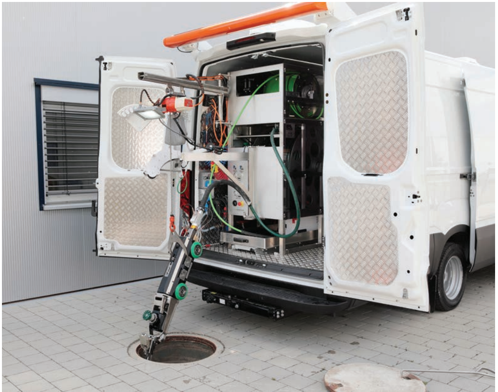
Weniger Lärmbelastung und Abgase bei Kanalarbeiten durch den Generator und das Hydraulikaggregat im Versorgungsfahrzeug. Möglich machen das Kleinstantriebe.
