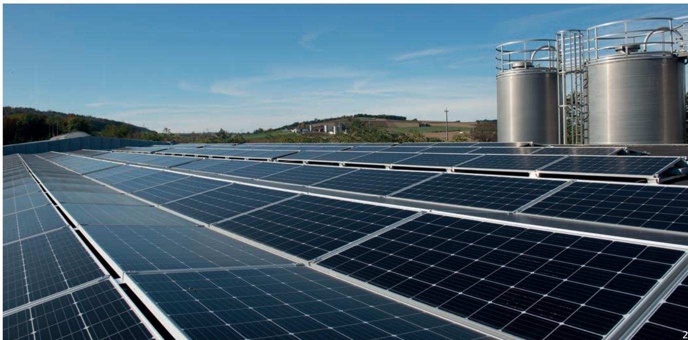
Ein Solarkraftwerk am Dach der MIRAPLAST-Zentrale in Würmla erzeugt ca. 30 Prozent des jährlichen Stromverbrauches.
