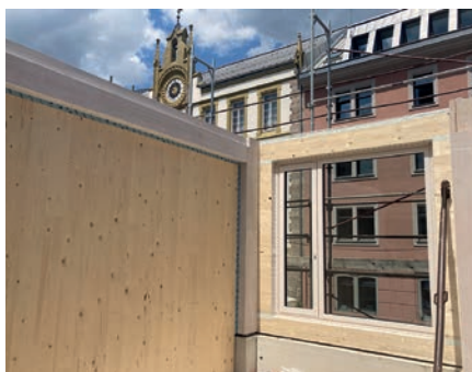
Ansicht von innen: Träger aus Baubuche und Wandelemente aus Fichtenholz.
