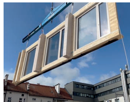
Die ersten Wandelemente wurden bereits montiert.
