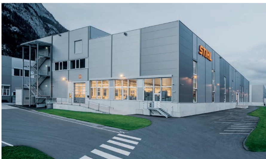
Die neue Kunststoff-Fertigung wurde im September 2022 in Betrieb genommen. Der Erweiterungsbau mit einem Investitionsvolumen von rund 19 Mio. Euro ist ein starkes Bekenntnis der Stihl-Gruppe zum Standort Langkampfen.
