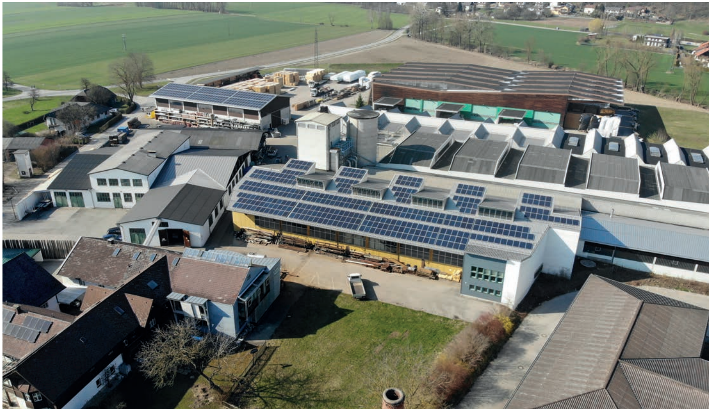
Das Firmengelände in Schwanenstadt bildet mit den modernen Fertigungshallen das Herzstück der Obermayr Gruppe.
