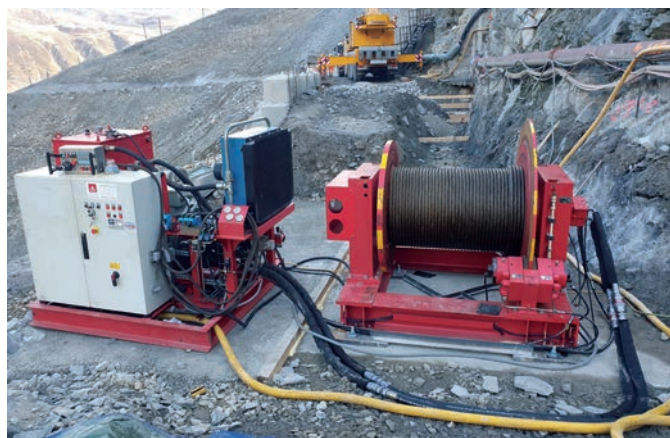
Aufstellung einer Seilwinde
