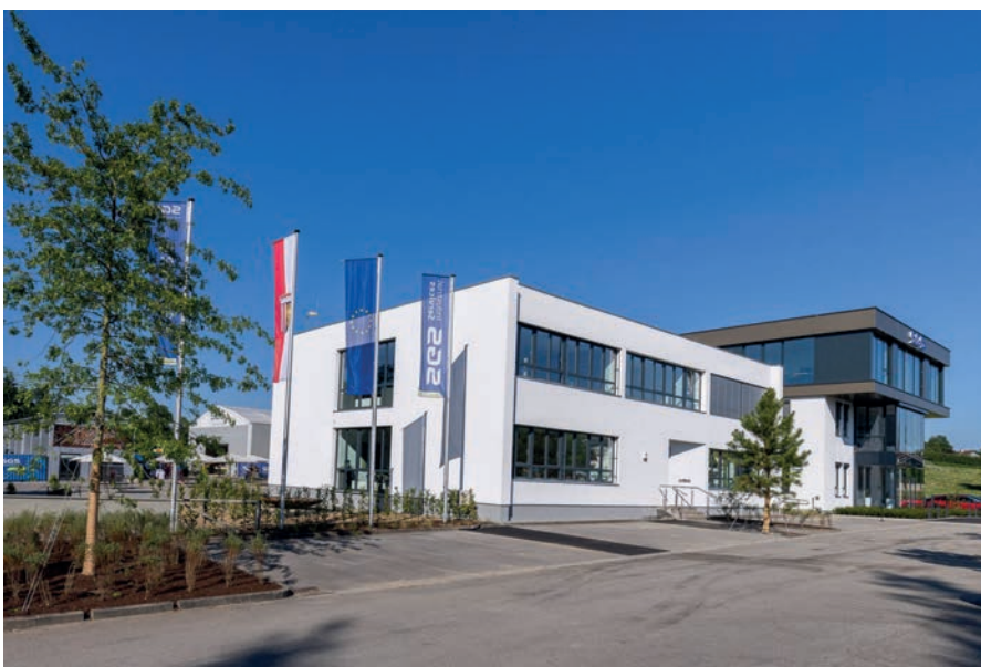
Das Bürogebäude in Dorf an der Pram wurde in einjähriger Bauzeit modernisiert und aufgestockt.
