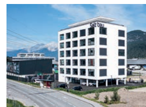
2023: 50-Jahr-Jubiläum. Pünktlich zur Jubiläumsfeier wird das neue Bürogebäude „Salzbau“ fertiggestellt.
