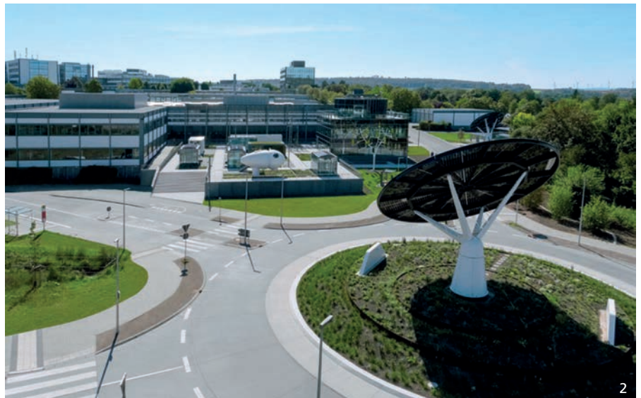
Ein Solarbaum mit einem Durchmesser von zwölf Metern ist das Erkennungszeichen des neuen All Electric Society Parks beim Blomberger Headquarter von Phoenix Contact.
