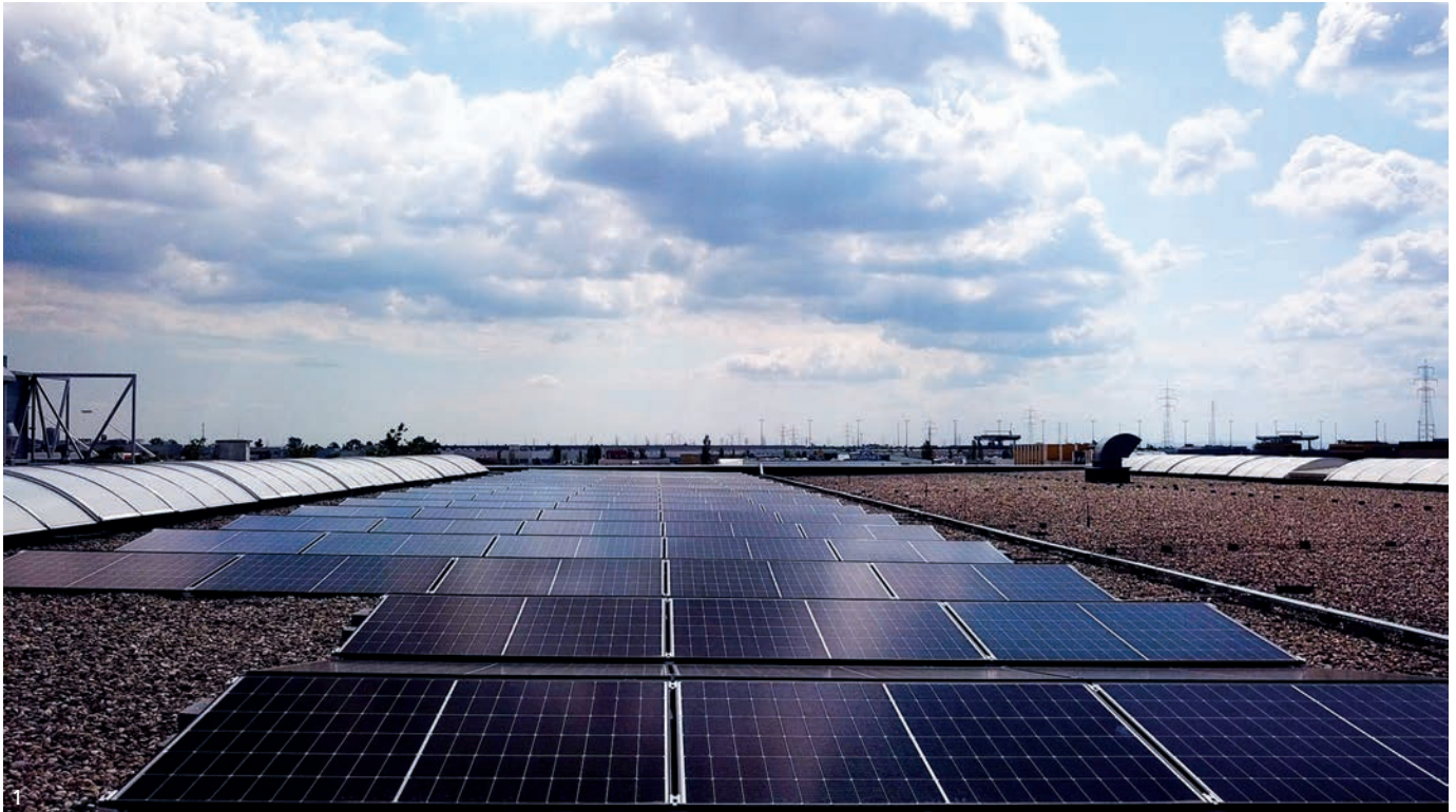
Rittal hat seit Neuestem eine Photovoltaikinstallation mit 150 kWp auf dem Dach seines Gebäudes in Wien in Betrieb.
