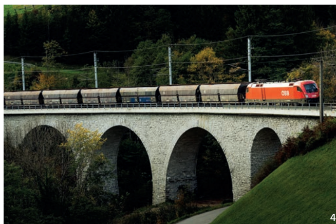
Mit dem Bau von Mini-Transformatoren ist soll der in den ÖBB-eigenen Wind- und Sonnenkraftwerken nachhaltig produzierte Strom ins Bahnstromnetz gelangen. Auch der Güterverkehr soll ausgebaut werden. Güterzuglange Überholgleise sollen es möglich machen.
