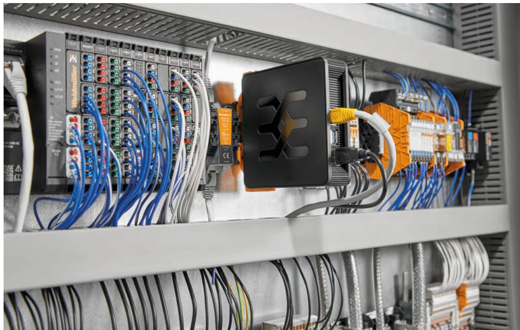
Das Weidmüller-Gehäuse für den Raspberry Pi 4 findet auch im Schaltschrank Verwendung.
