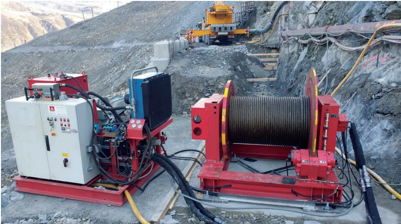
Aufstellung einer Seilwinde
