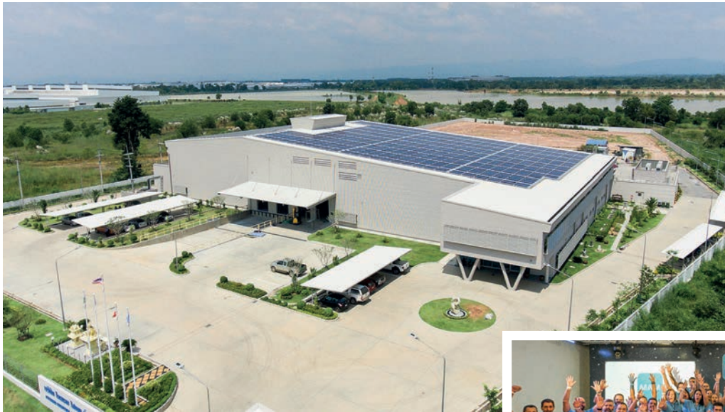
Das Mam-Werk im thailändischen Kabinburi deckt dank PV-Anlage 40 Prozent seines Energieverbrauchs ab (l.).
