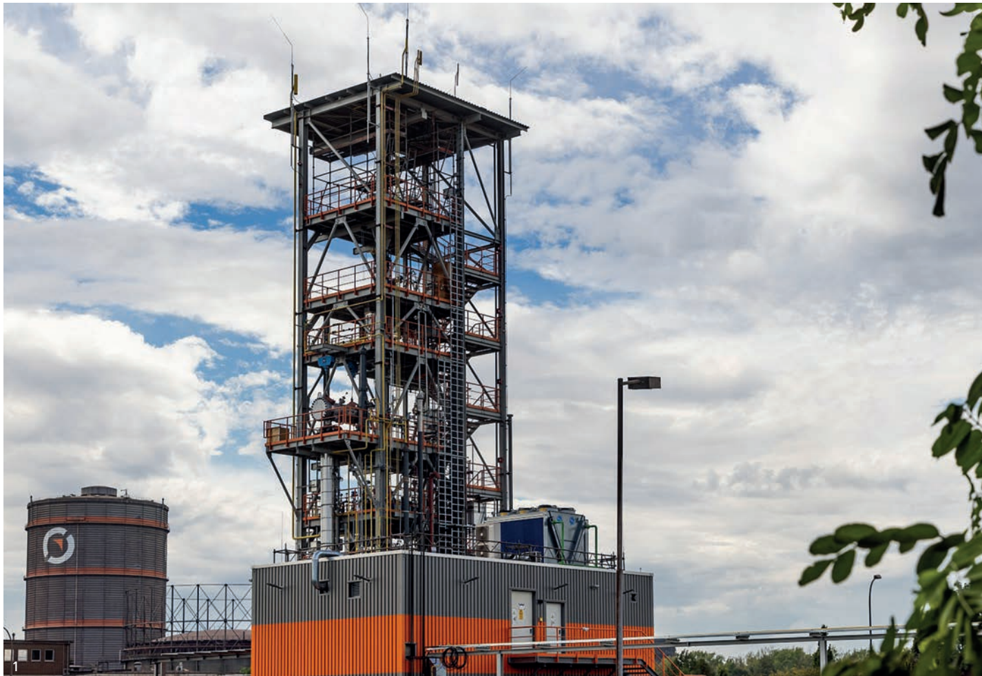
μDRAL-Anlage – erste flexibel mit Wasserstoff und Erdgas betriebene Direktreduktionsanlage in einem integrierten Hüttenwerk
