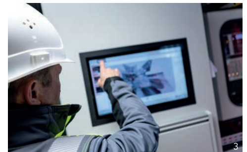
Die Infrarot-Brandmelder lösen automatisch Alarm in der Überwachungszentrale aus.
