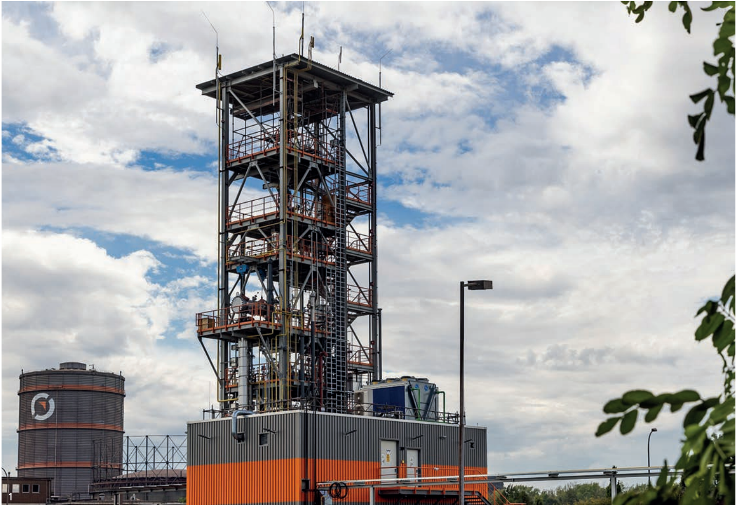
μDRAL-Anlage – erste flexibel mit Wasserstoff und Erdgas betriebene Direktreduktionsanlage in einem integrierten Hüttenwerk
