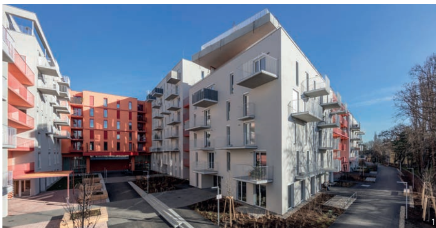
Das Wohnquartier Wientalterrassen verfügt über ein klimafittes System der Energieversorgung mit thermischer Bauteilaktivierung.
