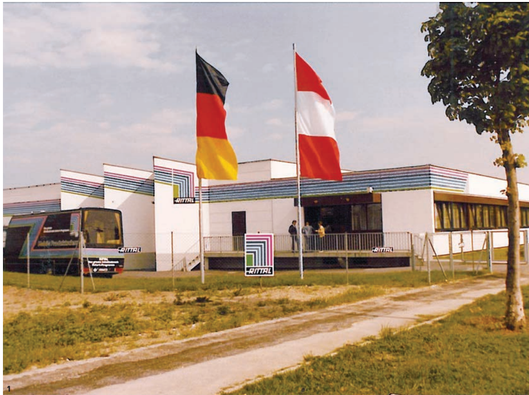
Ein wichtiger Schritt auf dem Weg zum Erfolg: die erste eigene Rittal-Niederlassung mit eigenem Lager in Wien in der Großmarktstraße 1983
