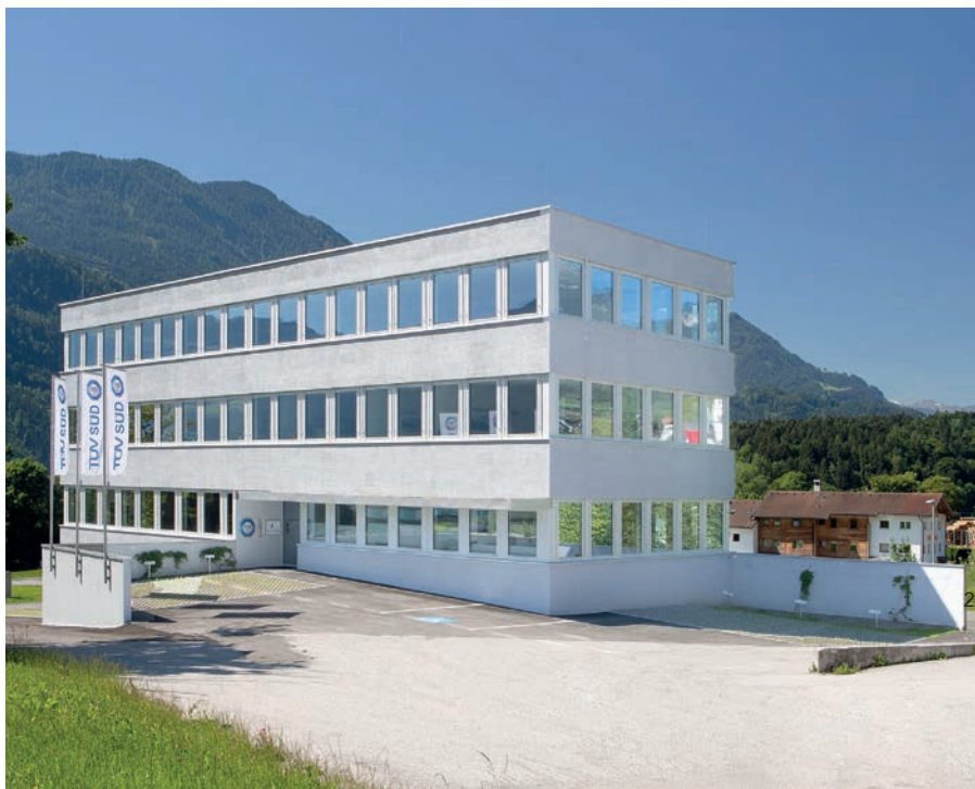
Das Internationale Kompetenzzentrum für Sicherheit und Seilbahnen des TÜV SÜD befindet sich in Wiesing/Tirol.
