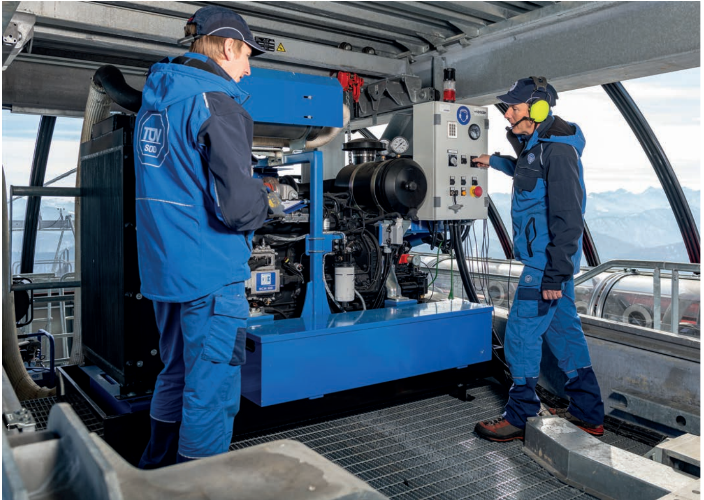
Die Seilbahnexpertinnen und -experten von TÜV SÜD sind weltweit im alpinen und urbanen Raum im Einsatz.
