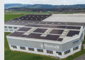
Photovoltaik Anlage mit einer Fläche von fast 1.000 m 2 am Dach des Firmengebäudes
