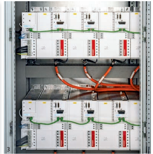
Der Bediener bekommt die Bathymetrie-Karte angezeigt. Sie ist auf das innere Becken der Roboterplattform zentriert (orangefarbenes Rechteck). Das rote Rechteck kennzeichnet den sicheren Arbeitsbereich, in dem es zu keiner Kollision zwischen Roboterplattform und -kabeln kommen kann (2). Servoverstärker AX5118 regeln die acht Windenantriebe des Seilroboters sowie die vier Achsen des Grundträgers (3).
