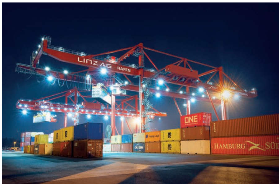
Das Ende 2023 errichtete 5G-Netzwerk im Hafen Linz beschleunigt Containerbewegungen durch die hochqualitative, unterbrechungsfreie Datenübertragung auf dem 120.000 m 2 großen Terminalareal.
