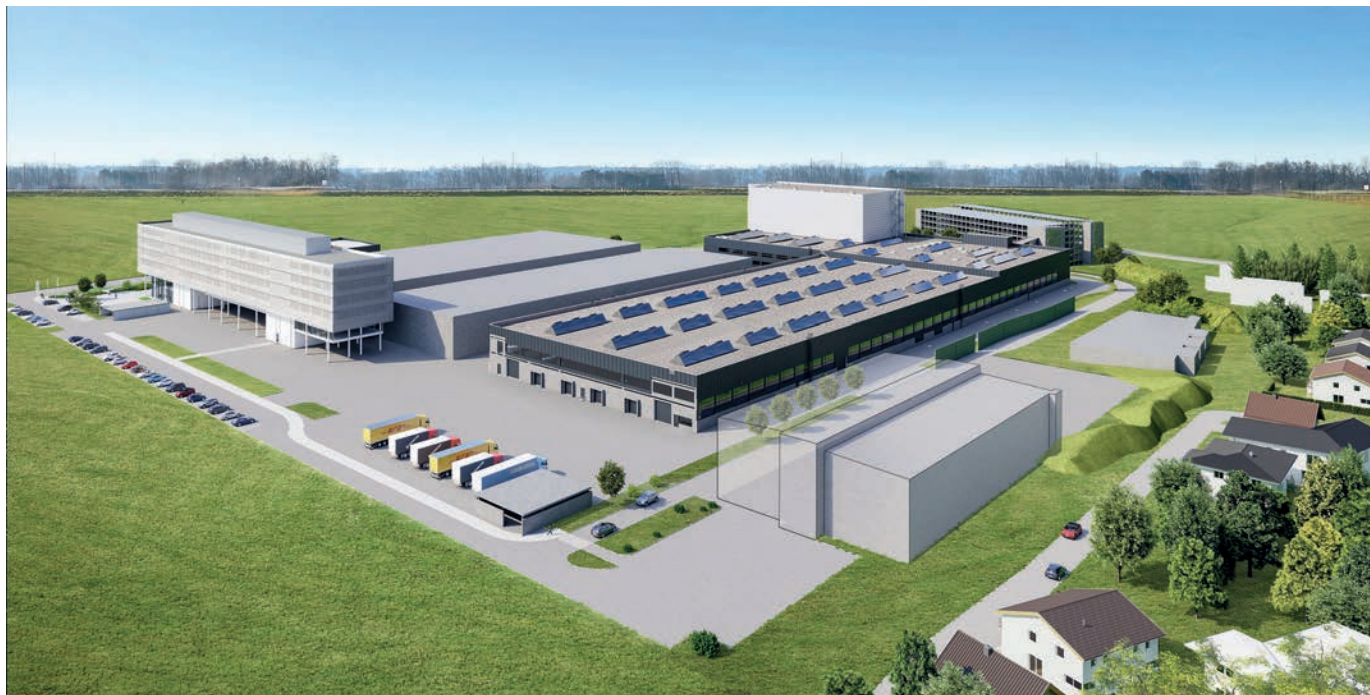
Bis Sommer 2026 entstehen in Marchtrenk ein 20.000 m 2 großes Produktionsgebäude sowie ein hochautomatisiertes Lagersystem für Paletten und Behälter auf 6.700 m 2 Grundfläche.
