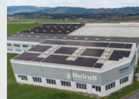
Photovoltaik Anlage mit einer Fläche von fast 1.000 m<sup>2</sup> am Dach des Firmengebäudes
