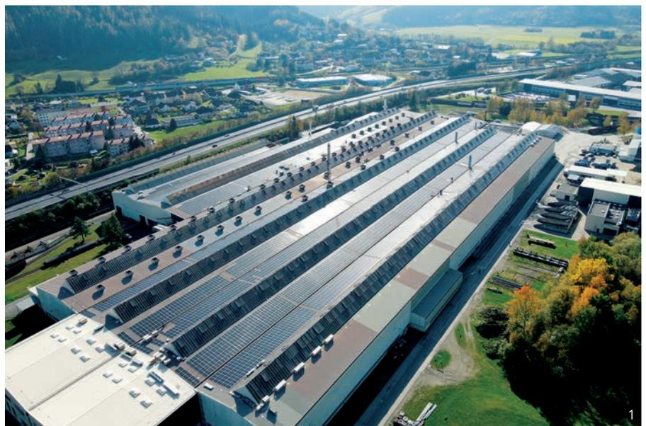
Der Sonnenstrom aus den PV-Anlagen führt allein am Standort Kindberg zu einer Reduktion von etwa 420 Tonnen CO<sub>2</sub> pro Jahr. Der Strom fließt direkt in die Prozesse und wird größtenteils am Standort verbraucht.
