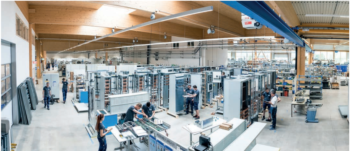
PMS betreibt in St. Stefan im Lavanttal eine der modernsten Schaltanlagenfertigungen Österreichs.
