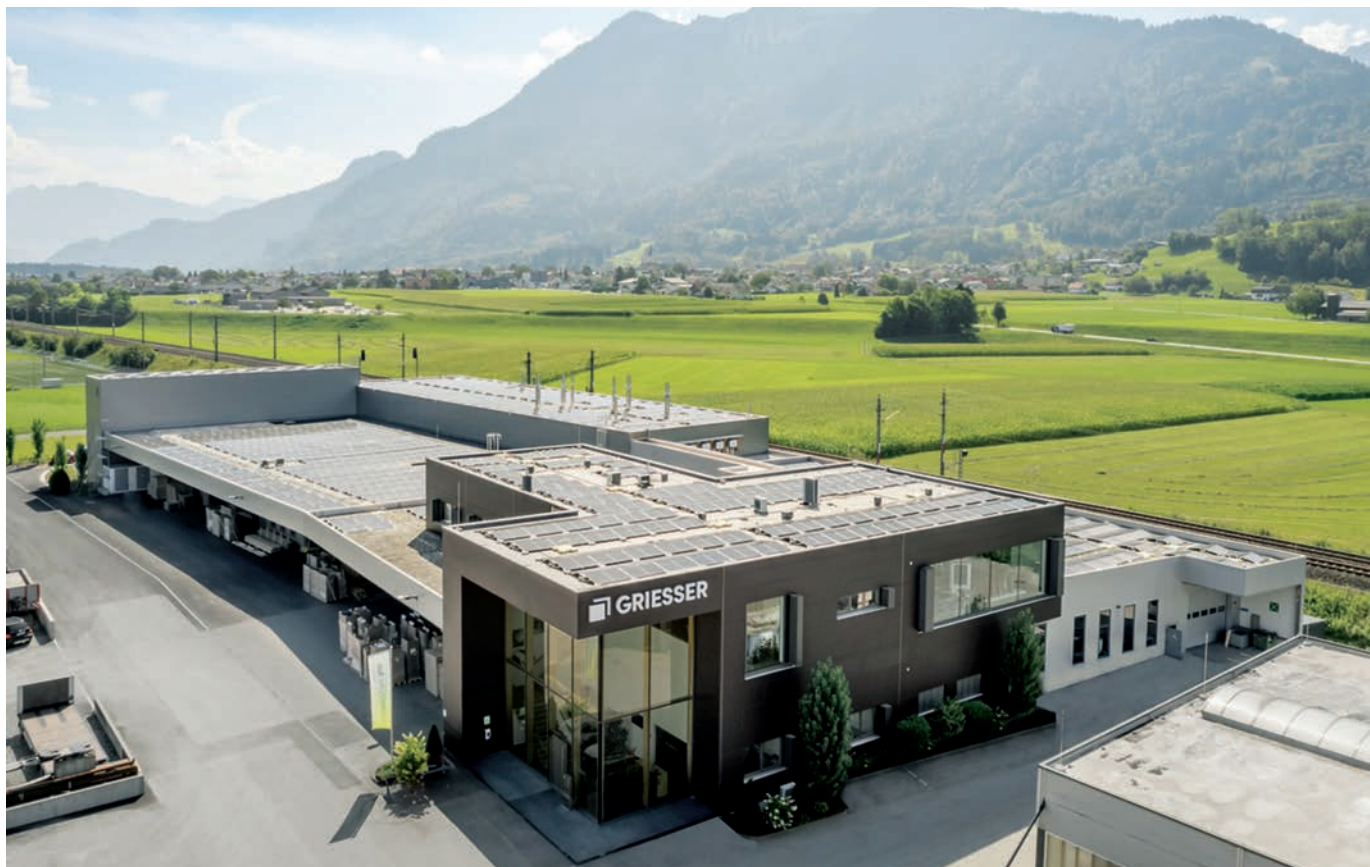
Die Photovoltaikanlage auf einer Fläche von rund 4.000 m 2 soll zwischen 80 und 100 Prozent des jährlichen Energiebedarfs abdecken.
