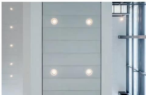
Damit das bisherige Akustikdeckensystem erhalten bleibt, entwickelte Zumtobel eigens einen Abdeckring für die neue Beleuchtungslösung, der in derselben Farbe beschichtet wurde wie die Decke selbst.
