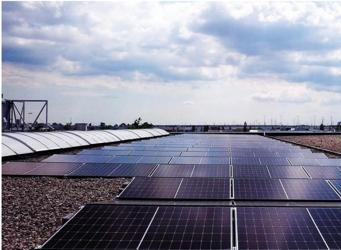
Das Rittal-Gebäude in der Wiener Laxenburger Straße wurde auf erneuerbare Energie umgestellt. Eine Photovoltaikanlage deckt den Großteil des Energiebedarfs, Luftwärmepumpen beheizen das Gebäude.
