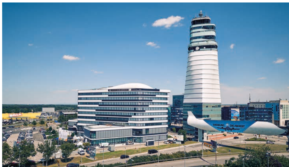
Flughafen Wien, Office Park 4, ÖGNI-zertifiziertes und taxonomiekonformes Bürogebäude der Vienna AirportCity
