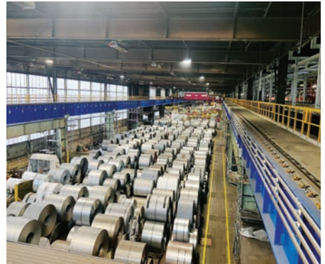
Kranbahnträgertausch bei voestalpine in Linz in Rekordzeit dank Digitalisierung
