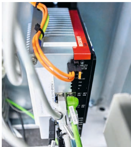
Der Ultra-Kompakt-Industrie-PC C6030 dient als leistungsfähiger Steuerungskern der BLS 500.
