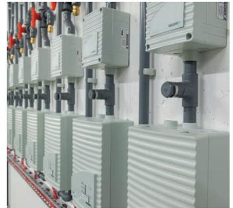
TITANUS®-Ansaugrauchmelder ermöglichen eine hochsensible Überwachung bei höchster Täuschungsalarmsicherheit.
