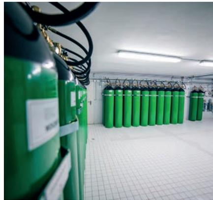
Das FirExting®-Gaslöschsystem – hier die Löschmittelbatterie – realisiert die rückstandsfreie Löschung.
