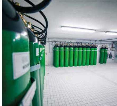
Das FirExting®-Gaslöschsystem – hier die Löschmittelbatterie – realisiert die rückstandsfreie Löschung.
