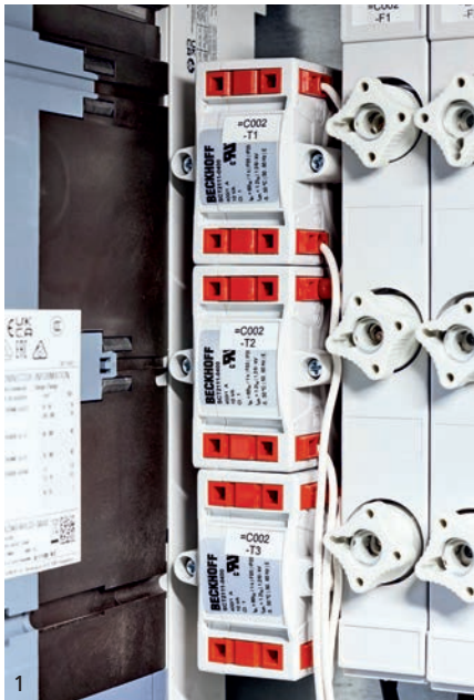
Der Energieverbrauch ist ein wichtiger Kostenfaktor in der Kunststoffindustrie, den BBM mithilfe der Durchsteckstromwandler SCT2111 und Energiemessklemmen EL3443 präzise erfasst (1). Die Heizzonen der bis zu sechs Extruder einer Blasformmaschine lassen sich flexibel in die modulare Steuerungsarchitektur einbinden (2).
