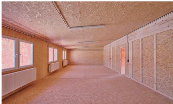
statisches System aus Brettschichtholzstützen und -trägern im Innenbereich ergänzt. Nicht tragende Innenwände bestehen aus OSB-Platten, die mittels Holzleisten an Boden und Decke befestigt wurden – reversibel, funktional und materialeffizient.
