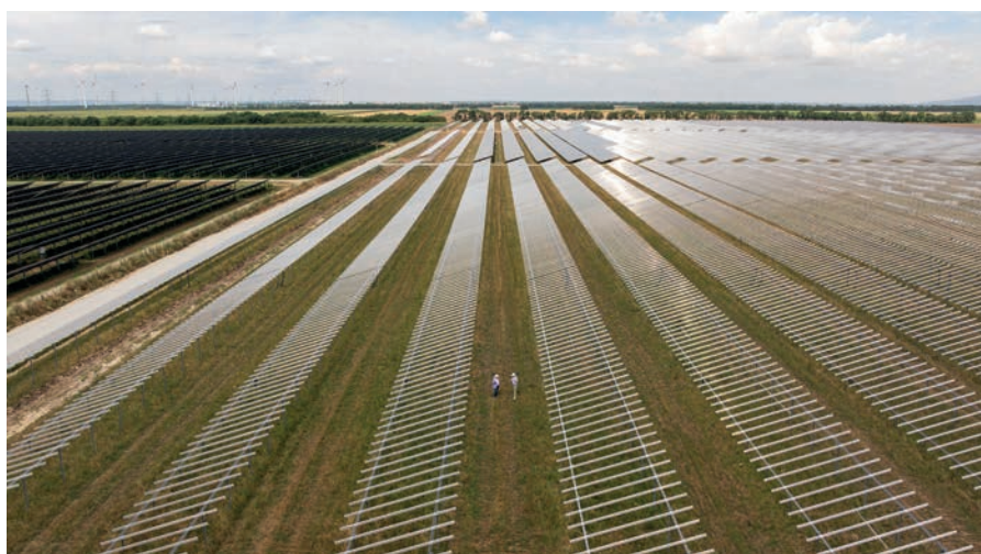
Bauphase Nickelsdorf II: Im Sommer 2024 nahm das Agri-PV-Projekt Nickelsdorf II auf 53 Hektar sichtbare Form an. Gerhard Zapfl, Bürgermeister von Nickelsdorf, und Lukas Püspök, Geschäftsführer der Püspök-Unternehmensgruppe, verschafften sich vor Ort einen Eindruck.
