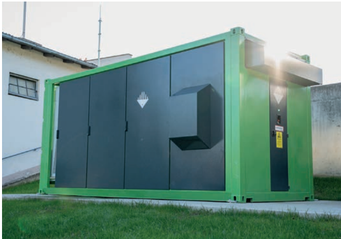
Der neue Strom-Großspeicher gleicht Schwankungen in der Energieeinspeisung aus (li.). Der neue Hochbehälter in Amstetten sorgt für autarke Wasserversorgung auch bei Stromausfall (re.).
