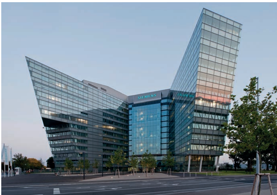
Das Hauptquartier der Siemens AG Österreich befindet sich in der Siemens City in der Siemensstraße 90, 1210 Wien (Floridsdorf). Der moderne Standort wurde 2010 eröffnet, gilt als energieeffizient (Green Building) und fungiert als zentraler Verwaltungssitz für den Technologiekonzern in Österreich.
