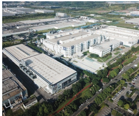
Bei AT&S in Chongqing wurde eine Plattform für intelligentes Energiemanagement implementiert.
