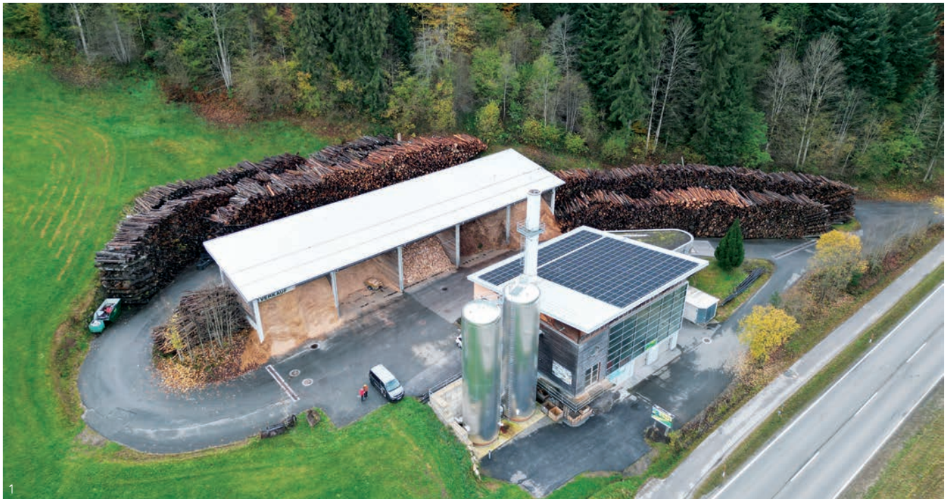
Beim Hackschnitzel-Heizwerk Söll setzt man für die Wärmeerzeugung auf Biomasse und steigert die Effizienz durch eine Wärmepumpe, einen Pufferspeicher und eine PV-Anlage auf dem Dach.
