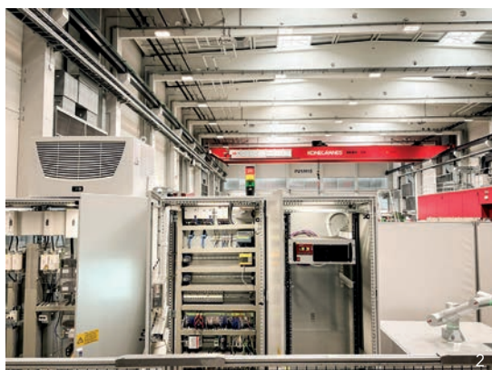
Der Schaltschrank der Austrian DC Pilot Factory steuert das Zusammenspiel von Photovoltaik, Produktionsanlagen und bidirektional ladenden Elektrofahrzeugen innerhalb des Gleichstromnetzes (Bild links). Bidirektional ladende Elektrofahrzeuge werden intelligent in das Energiesystem integriert und können überschüssige Energie speichern sowie bei Bedarf wieder bereitstellen (Bild rechts).
