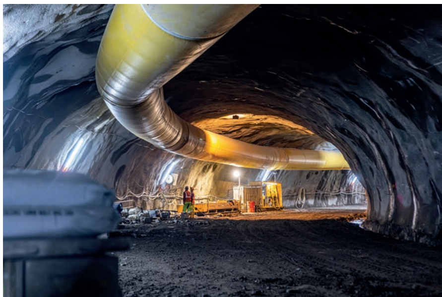
2032 wird der zweite Bauabschnitt der A26 Linzer Autobahn eröffnet und dann die Donautalbrücke an der B127 mit der A7 verbinden.
