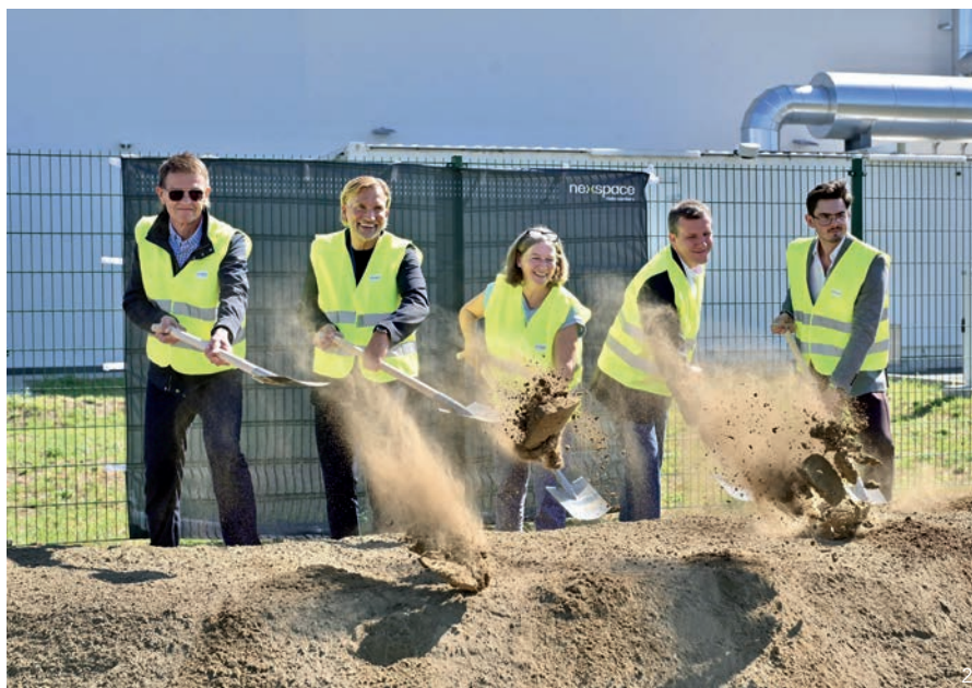
Mit dem Spatenstich erfolgte der offizielle Baustart des neuen nexspace-Rechenzentrums in Graz.
