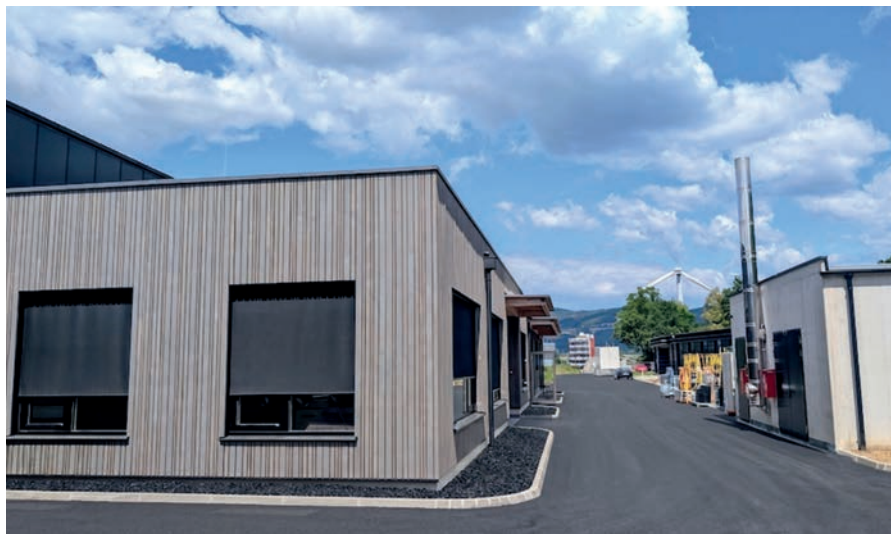
Kapo erzeugt mit seiner PV-Anlage und dem eigenen Biomasse-Heizkraftwerk mehr Energie, als für die Produktion benötigt wird.
